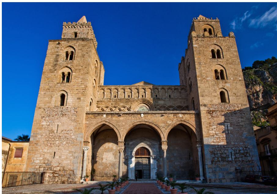
Fig. 1 - Cefalù, cattedrale. Prospetto principale
